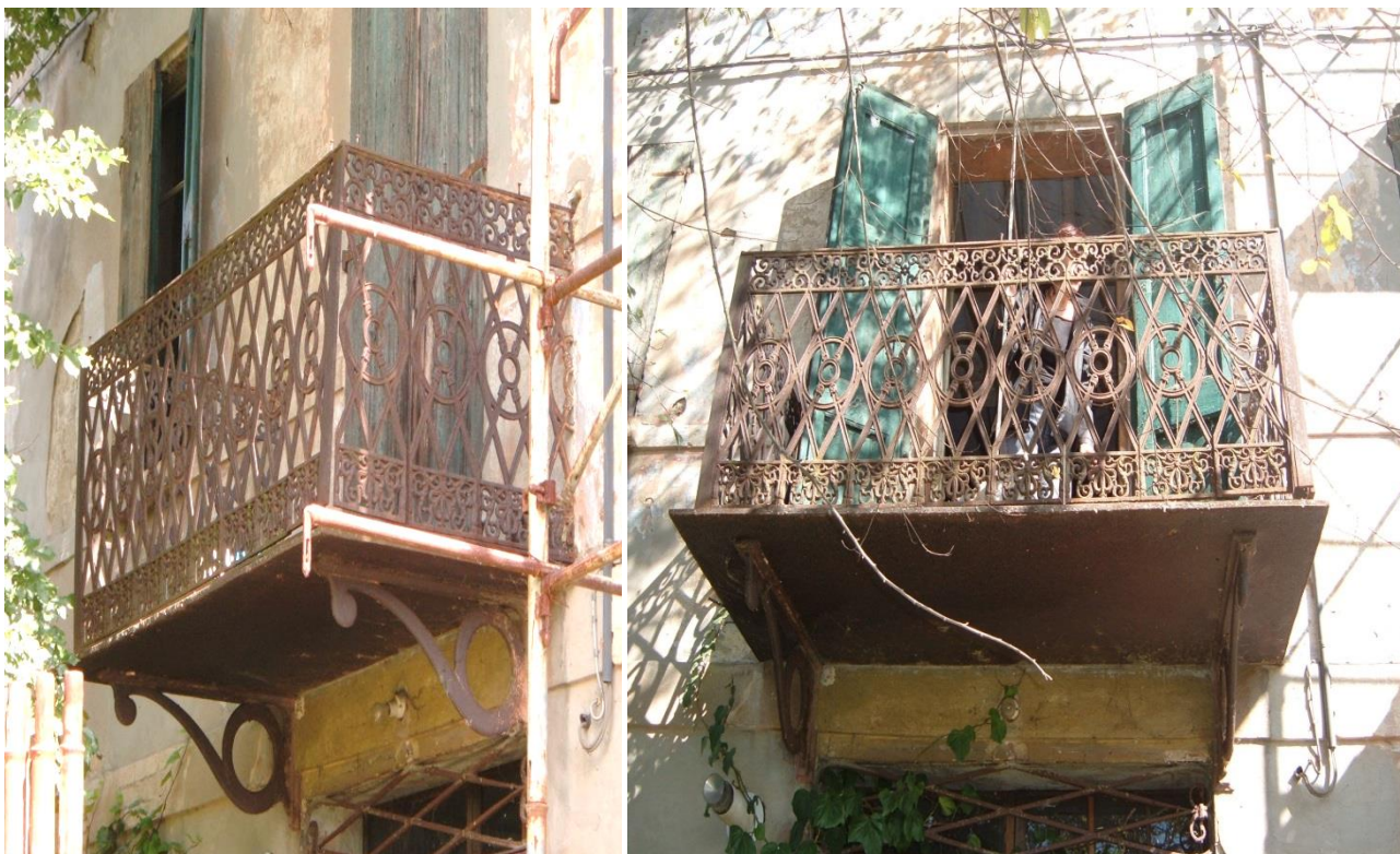
Figura 3 - Particolare della ringhiera del terrazzo realizzato in facciata della parte residenziale del complesso colonico
